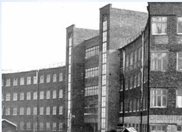
Строящийся корпус Московского института инженеров связи (МИИС)
