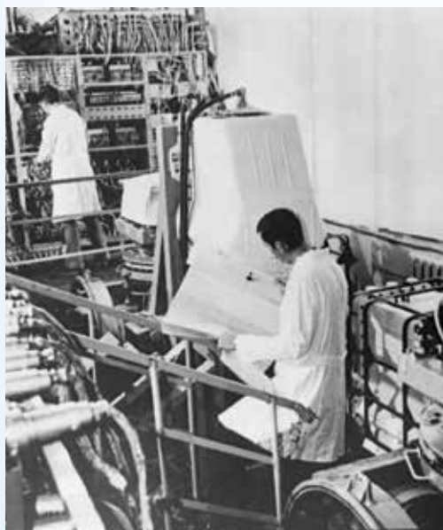
Стенд КАУ центрального блока 2-й ступени РН «Энергия»
